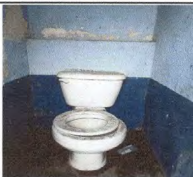
Foto 9: Sustitución de inodoros
