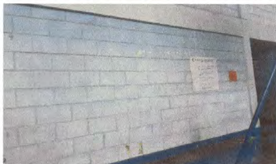
Foto 7: Pintura en muros exteriores e interiores
