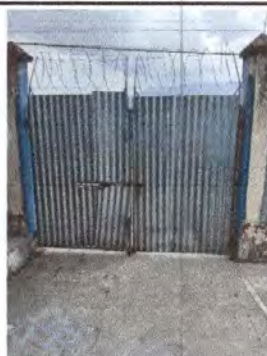
Foto 4: Sustrucción de portón de metal
