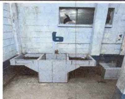
Foto 6: sustitución de Vidrios
