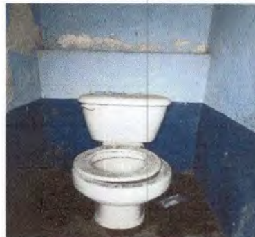
Foto 8: Sustitución de accesorios
